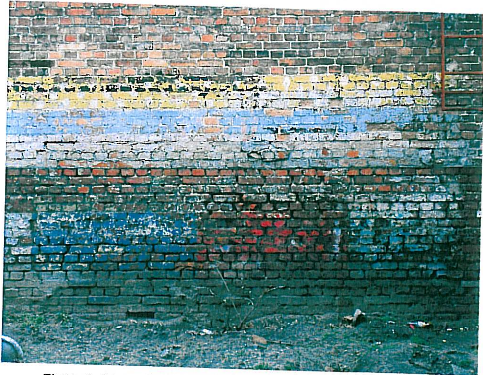
Elewacja tylna – środkowy fragment ściany od strony działki nr 14
