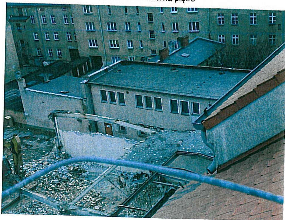
Widok na dach budynku
