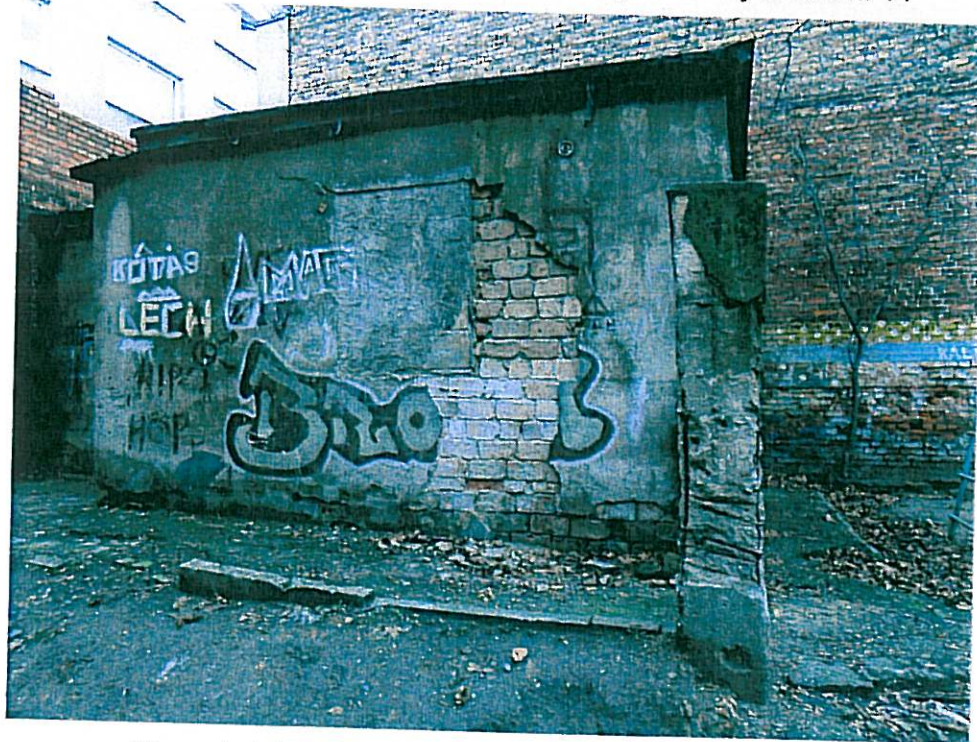
Elewacja tylna na styku z budynkiem m1 na działce nr 14
