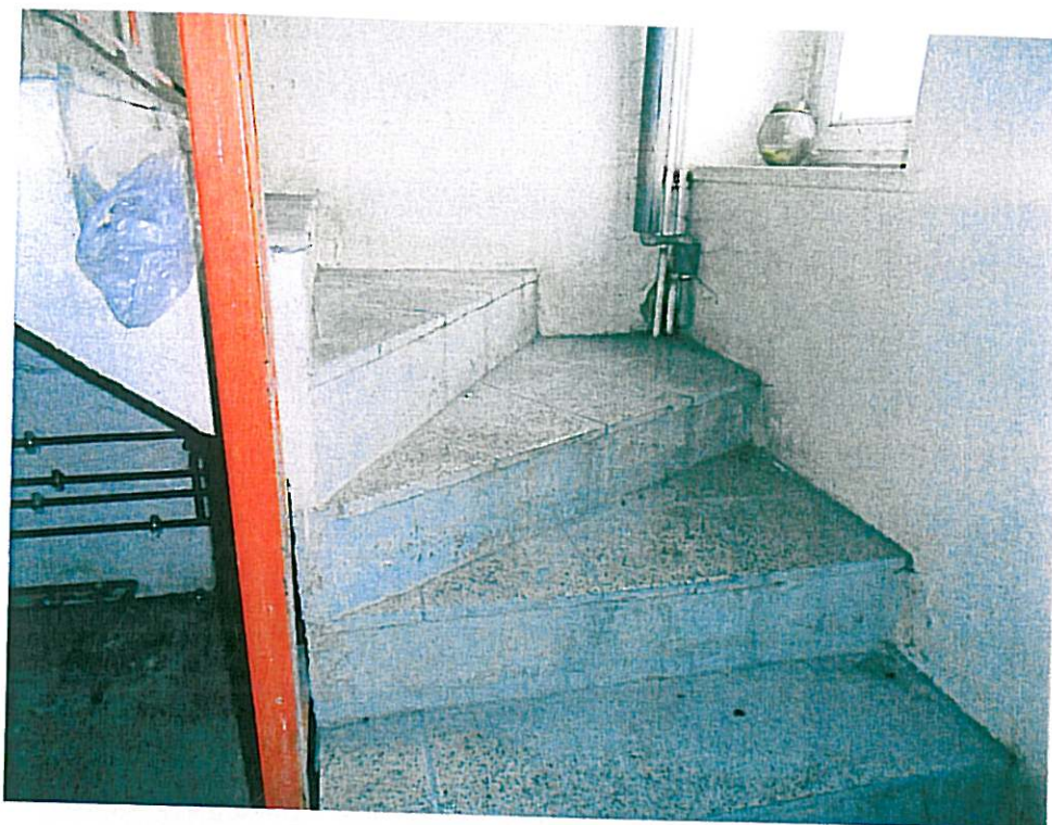
Klatka schodowa na piętro
