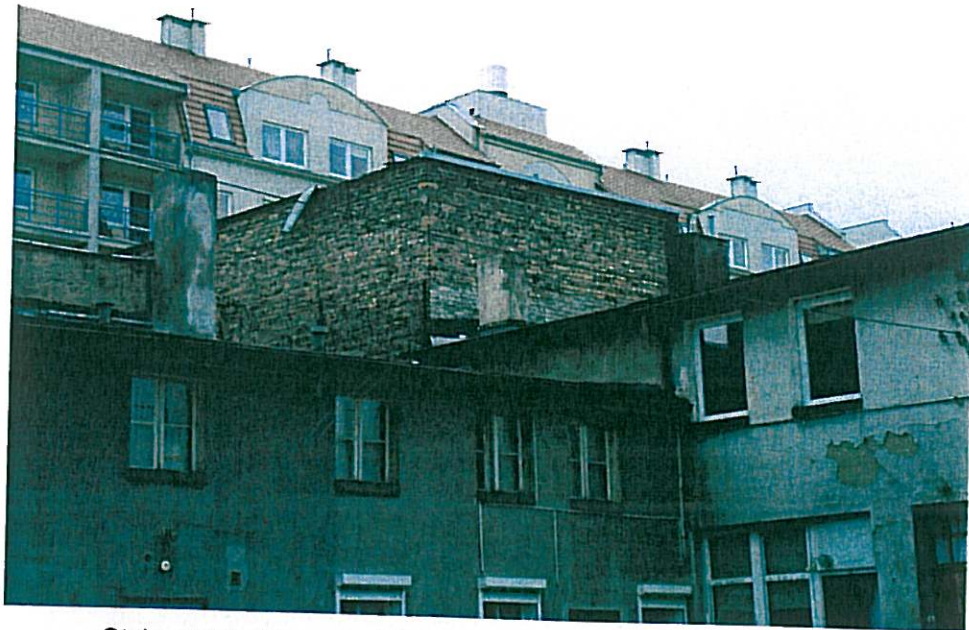
Styk z budynkiem na działce nr 15 widok od strony działki nr 15
