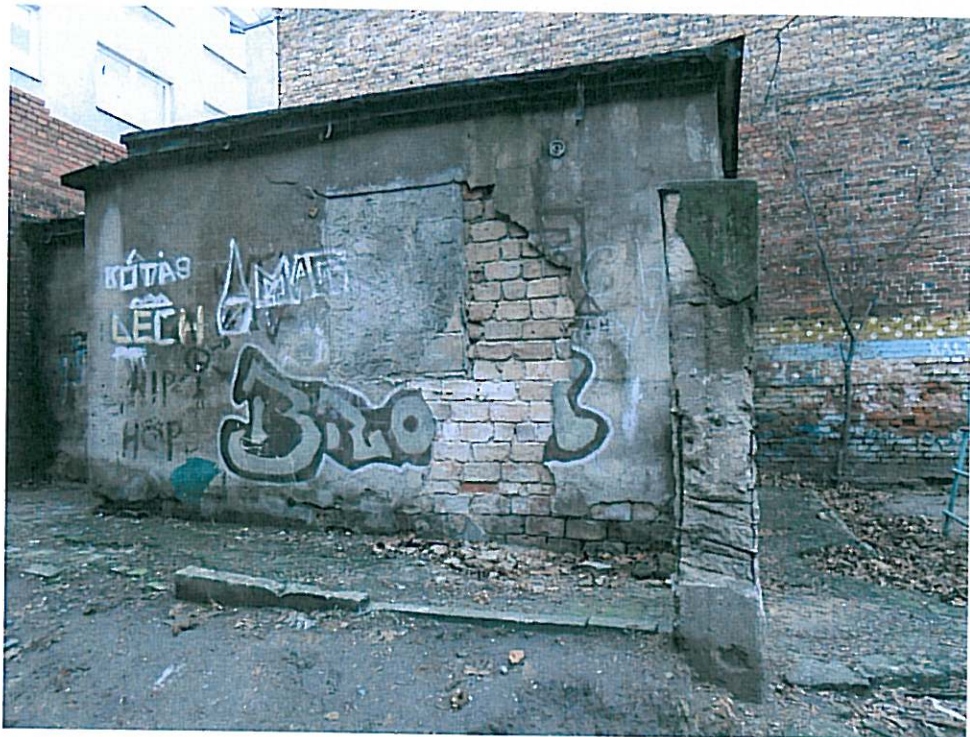
Elewacja tylna na styku z budynkiem m1 na działce nr 14
