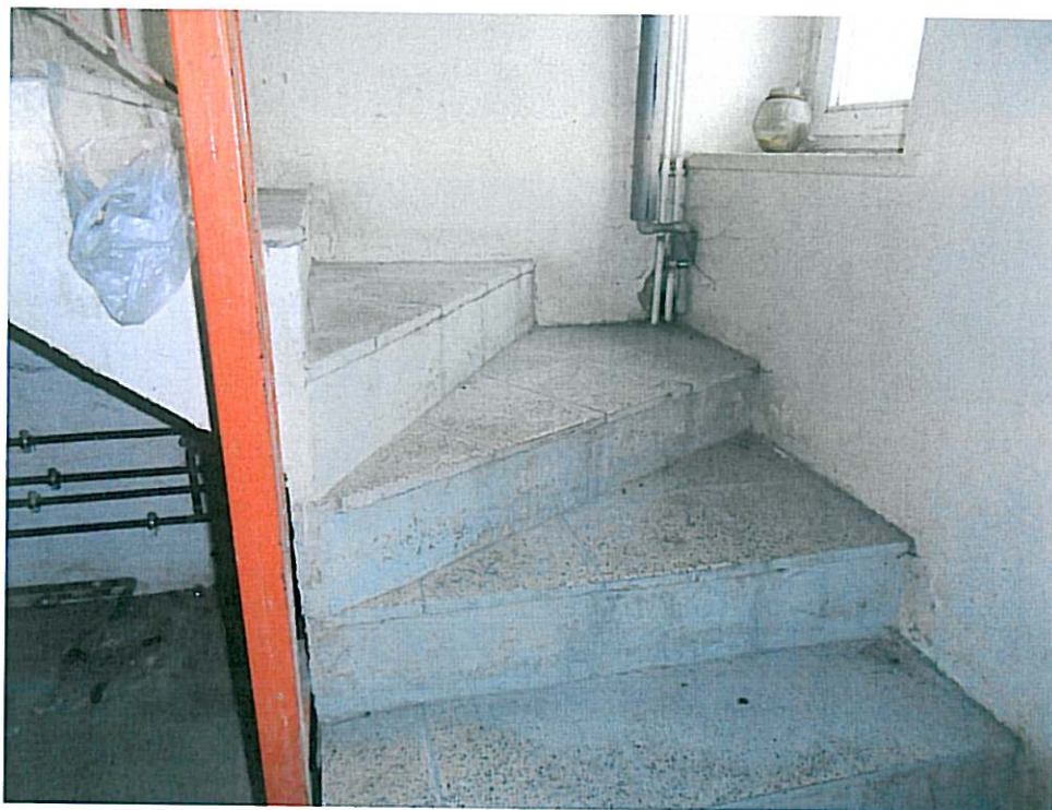
Klatka schodowa na piętro
