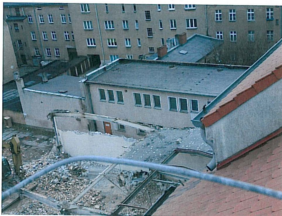
Widok na dach budynku
